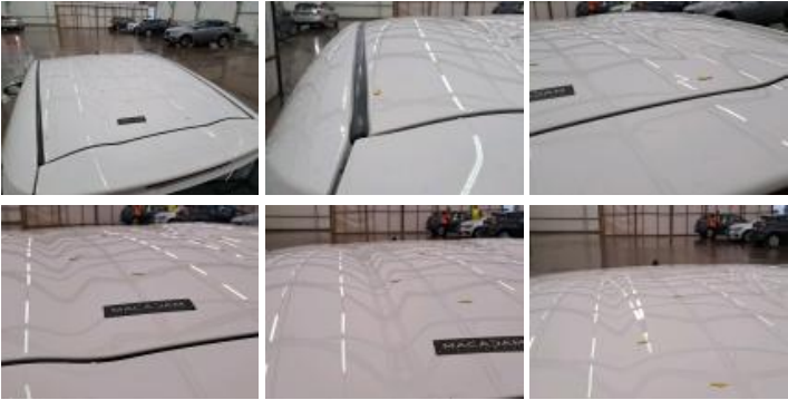
Pavillon, Grêlé, LI - Réparer et peindre (complet)
